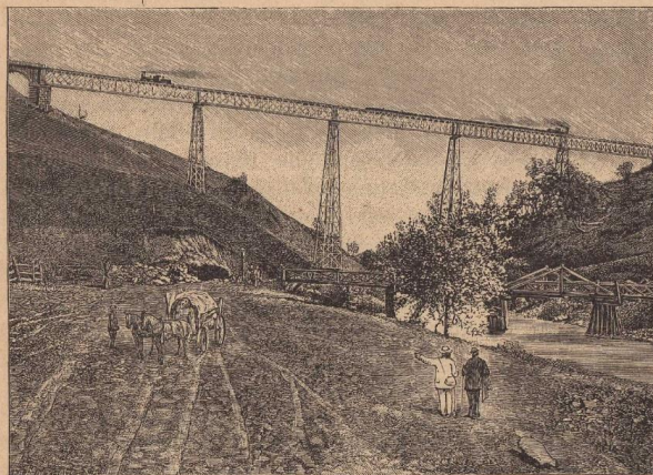
BRÜCKE DER SÜDBAHN. MALLECO.
