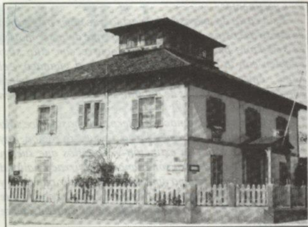
En las esquinas de las calles Atacama y Rancagua, se encuentra la imponente residencia conocida como Casa Maldini, cuya construcción prefabricada le permitió ser trasladada desde Caldera -donde fue levantada originalmente- hasta Copiapó.
